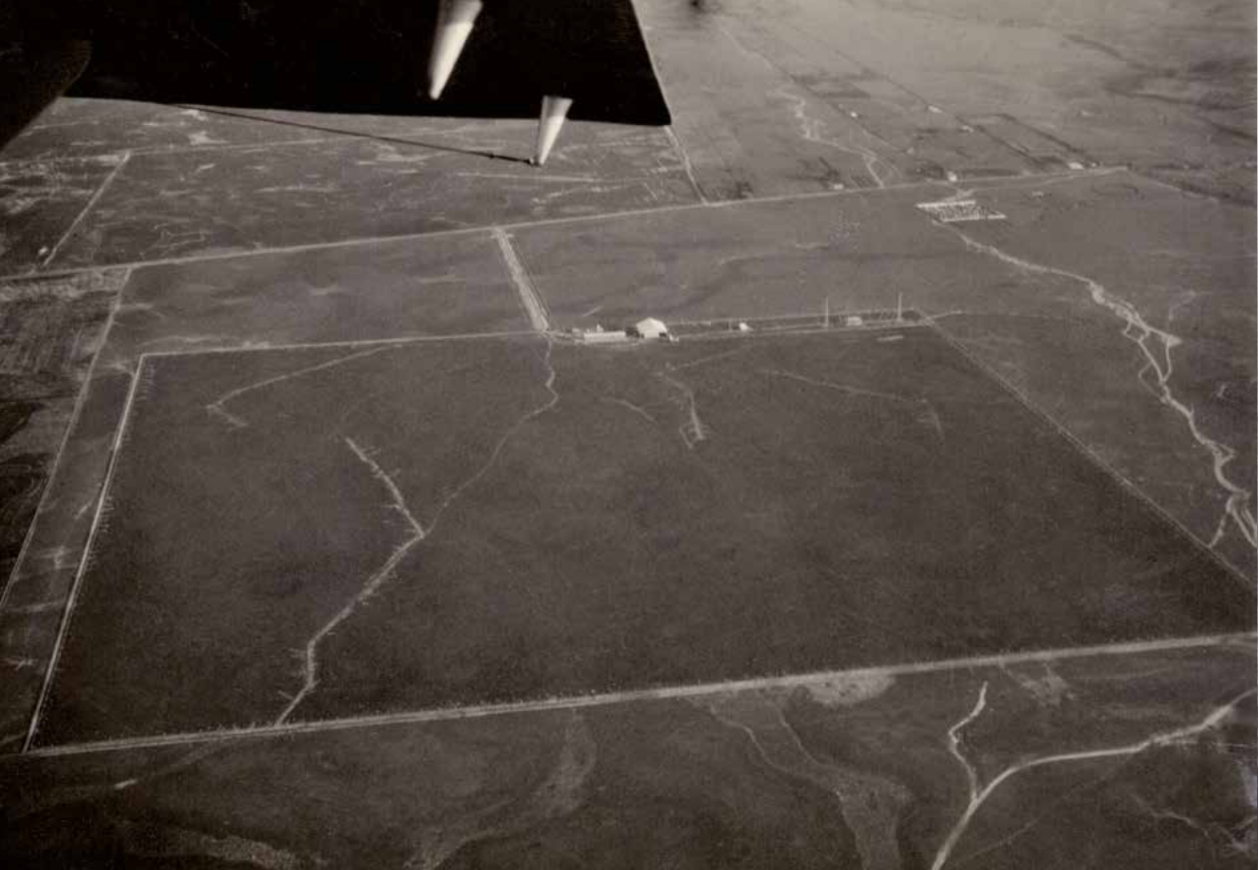
Aeródromo de Pelotas, Rio Grande do Sul: 800 m x 800 m. Da esquerda para a direita: o prédio de acomodação de funcionários, o hangar e, na extremidade, a estação de rádio com dois mastros (Coleção Museu Air France).
